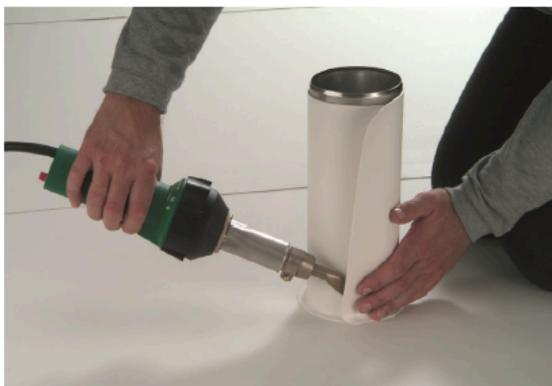
figura 32. Soldadura del cordón vertical
