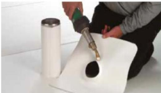
figura 30. Instalación de tubería con soplete
