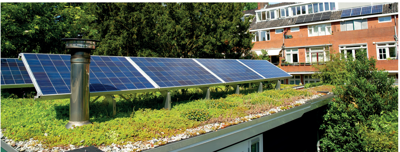
Cubierta solar bioclimática con protección pesada
