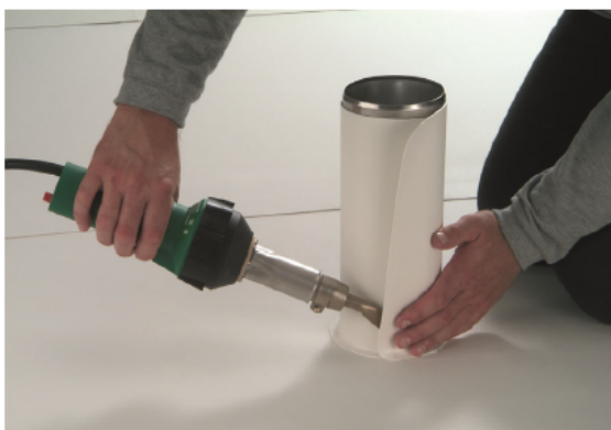
Figura 34. Soldadura del cordón vertical.
