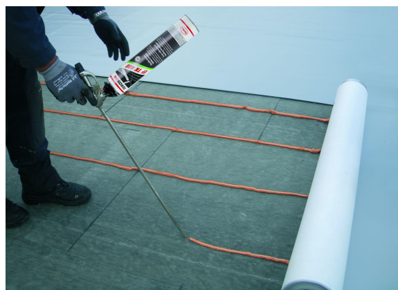
Figure 11. Aplicación en cordones de Tersoson EF TK 400
